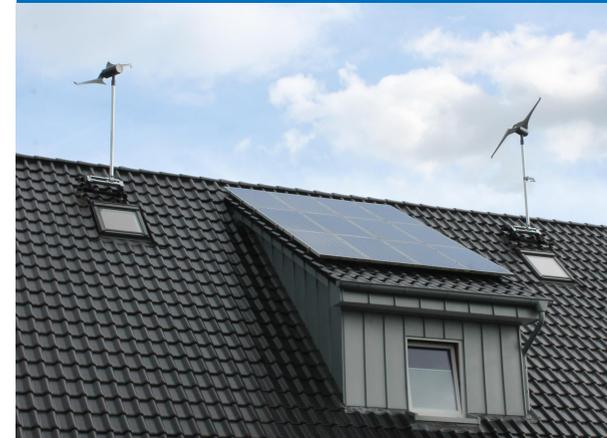
Entkoppelte Aufdachmontage auf Solarschiene (vgl. S. 22)
